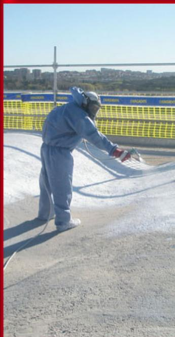
**Rivestimenti Impermeabilizzanti tramite l'uso di una Membrana Liquida Continua in Poliuretano Elastico**
